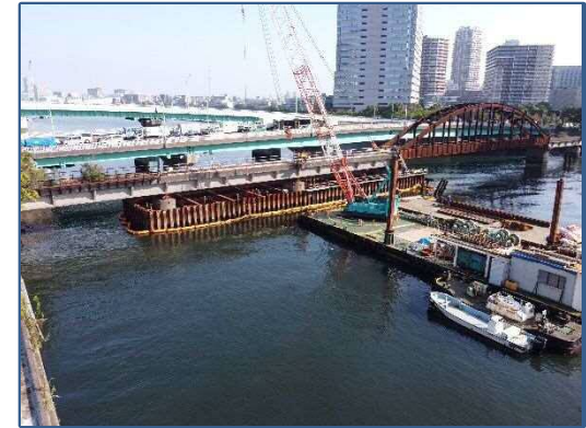
矢板打設完了 令和3年10月
