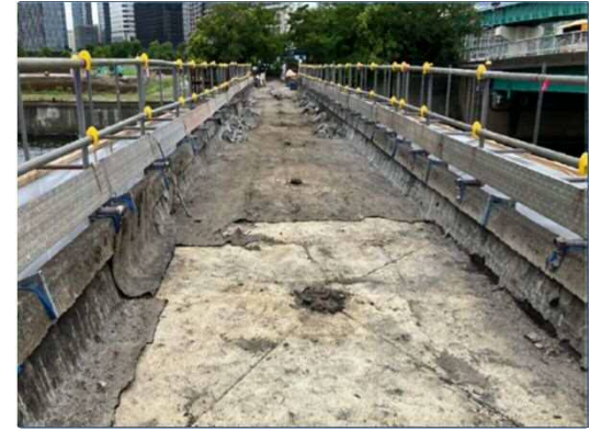
バラスト撤去完了 令和5年8月
