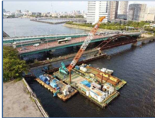
矢板打設工 令和3年8月
