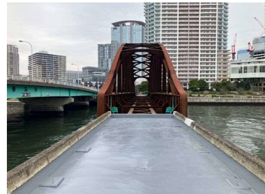
上部工補修完了 令和6年3月
