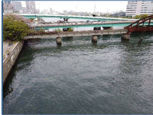
着工前 令和3年4月
