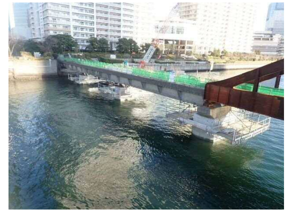
橋脚補強完了 令和5年2月
