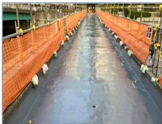
防水層設置完了 令和6年3月
