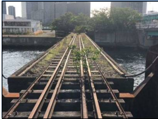
着工前 令和5年2月
