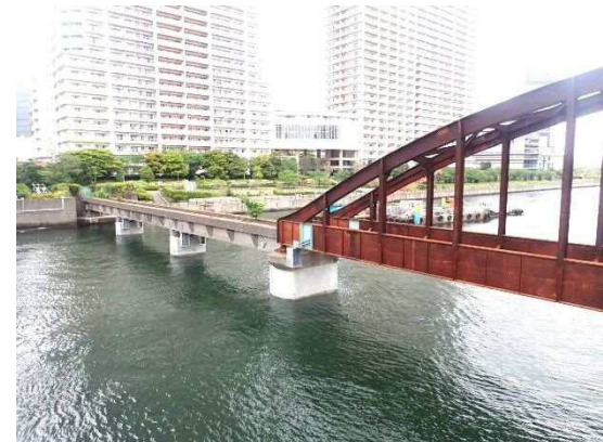
耐震補強工完了 令和5年4月
