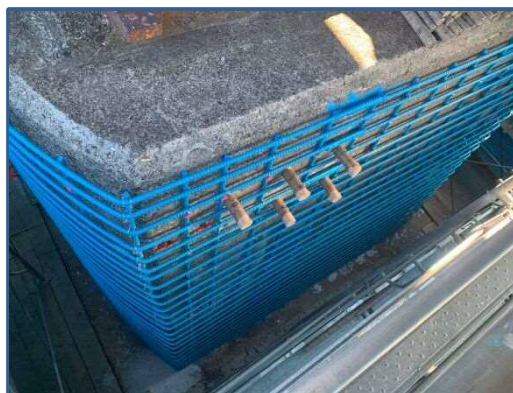
鉄筋組立完了 令和3年12月
